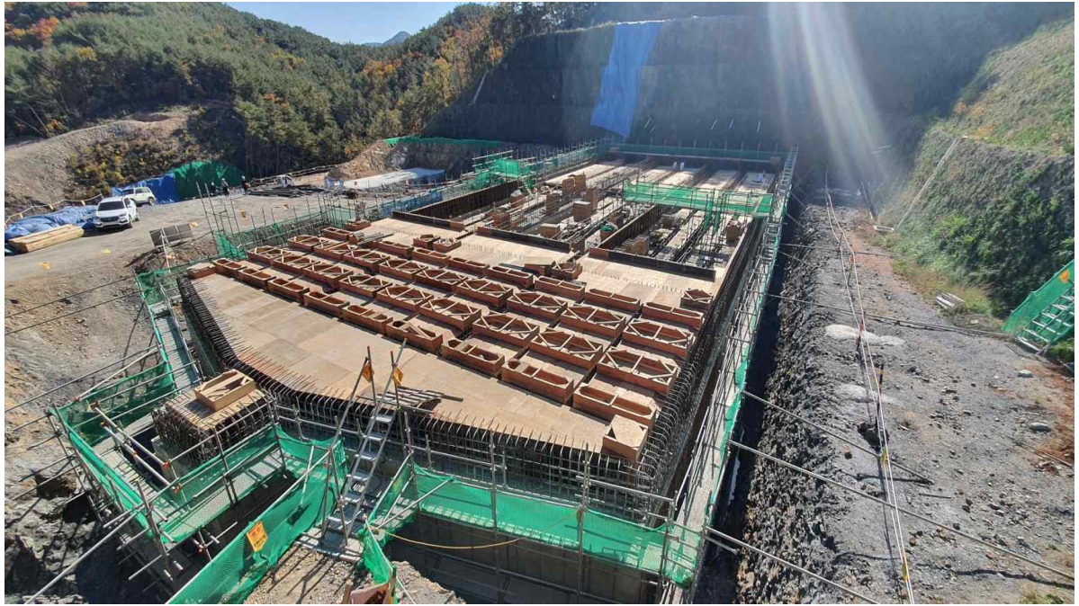
단양정수장 구조물 시공 사진
